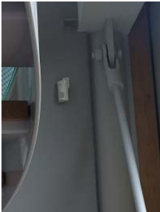
PIR richt zich op trappenhuis
